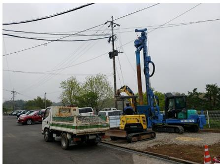
詳細⇒エコジオ工法は、専用のEGケーシング（特許取得済）を用いることで、地下水のある軟弱な地盤でも掘削した穴の崩壊を防ぎ、安定した品質を保ちます。このEGケーシングの側面から砕石を投入することが出来る為、機械を小型化できたことで住宅地盤の改良に使用できるようになりました。
